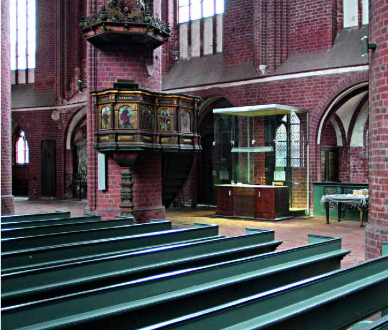
Beim Einbau dieser transparenten Wächterloge wurde die historische Substanz des Kirchengebäudes kaum angetastet: Nur zwei Schraubverbindungen fixieren die Konstruktion am Mauerwerk.
